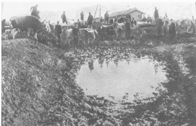
2. Ἀνατολική Μακεδονία: Γύρω ἀπὸ ἓνα ἀρτεσιανὸ φρέαρ, ἐργασίες ἐπιχωμάτωσης
