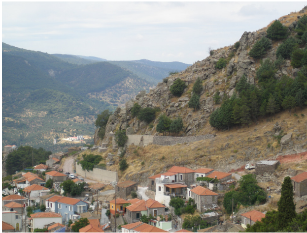
Fig. 2. Rock slope overhanging the village of Stypsi where rockfalls have occurred. Εικ. 2. Πλαγιά ανάντι του χωριού Στύψη στην οποία έχουν εκδηλωθεί καταπτώσεις.
