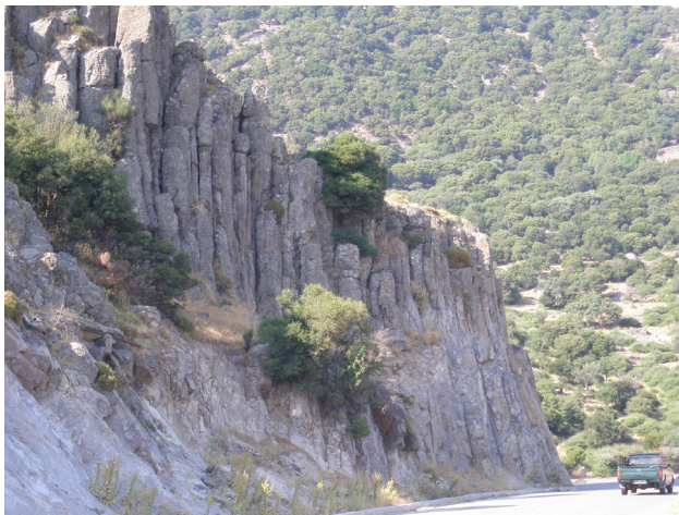
Fig. 3. Slope in andesitic lavas, prone to toppling failure. Εικ. 3. Πρανές σε ανδεδαιτικές λάβες, αστοχία υπό μορφή ανατροπής.
