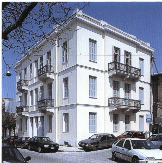
Το κτίριο του υπό ανέγερση Μουσείου Ισλαμικής Τέχνης (φωτ.: Σπ. Δεληβορριάς).
