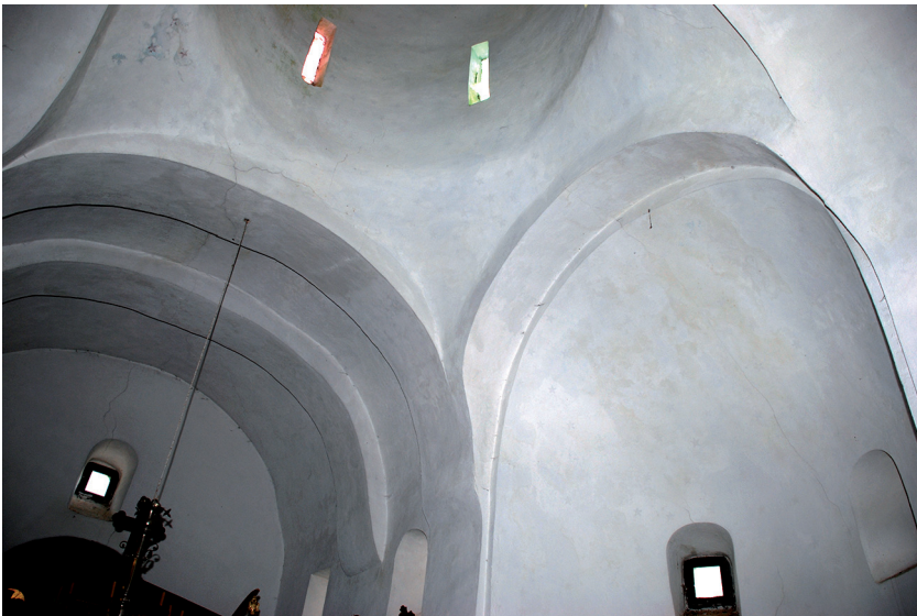
Εικ. 20. Η ανωδομή. Λεπτομέρεια: η στήριξη του συνεπτυγμένου τρούλλου.
