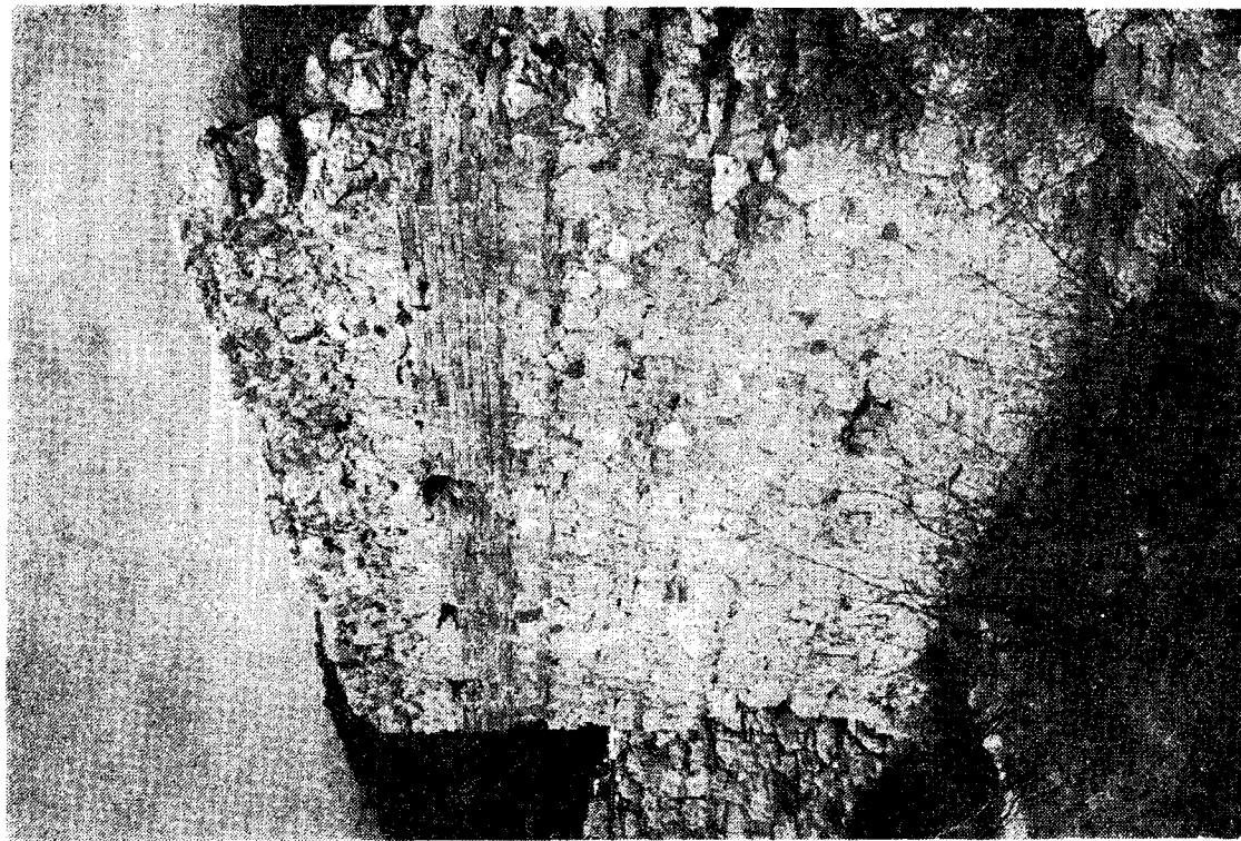
Εικ. 2. Βόρειος τοίχος.
