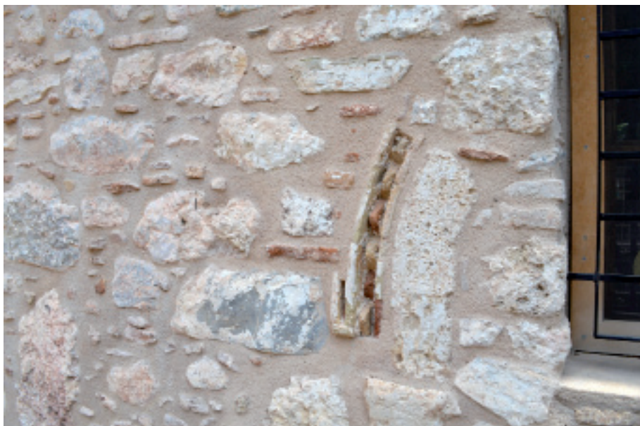
Εικ. 3: Άγιος Ιωάννης ο Προδρόμος στο Μενίδι. Νότιος τοίχος, τμήμα πεταλόμορφου τόξου, που έστεφε άνοιγμα θύρας (άδεια φωτ.: © ΥΠ.ΠΟ/Εφορεία Αρχαιοτήτων Δυτικής Αττικής).
