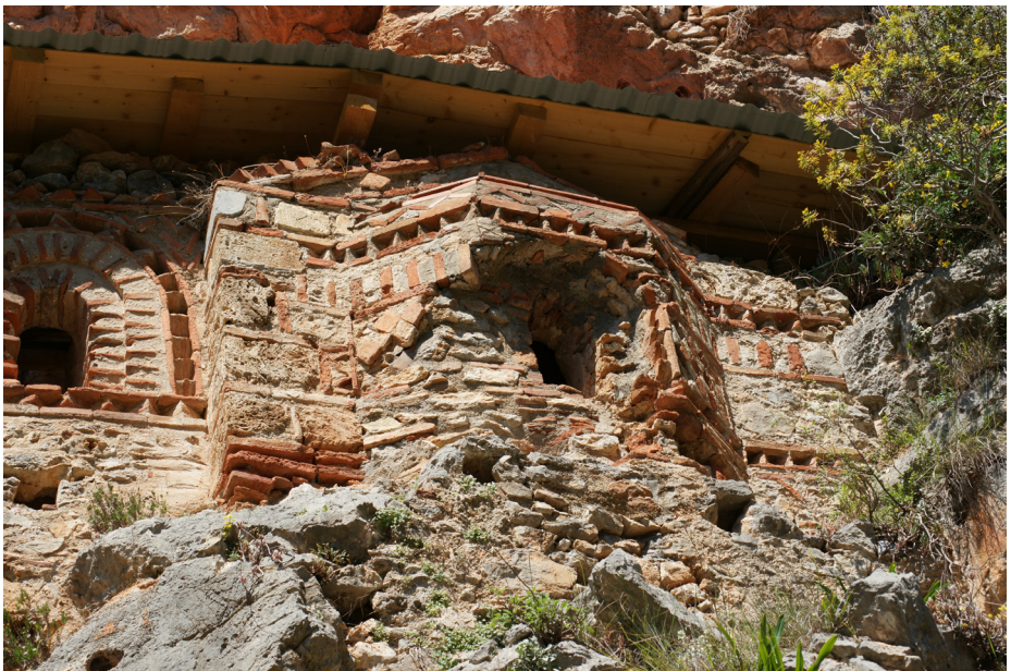
Εικ. 36. Ρέμα Σωφρόνη, Ασκητήριο Προδρομού, άποψη της αψίδας (2011).
