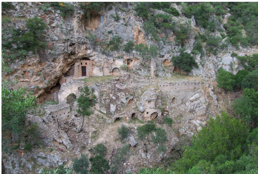
Εικ. 33. Ρέμα Σωφρόνη, Παλιομονάστηρο, γενική άποψη (2011).
