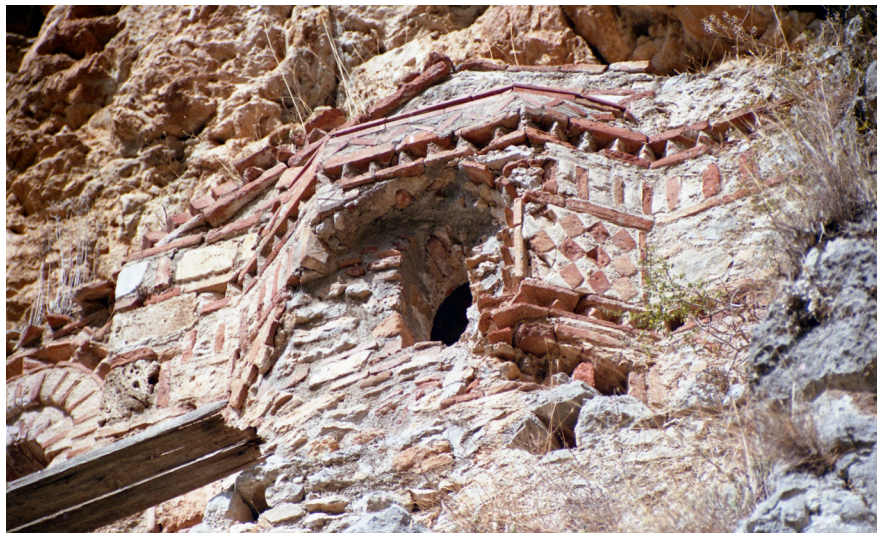
Εικ. 37. Ρέμα Σωφρόνη, Ασκητήριο Προδρόμου, άποψη της αψίδας (2004).
