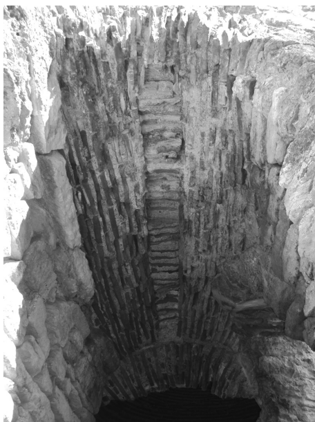
Εικ. 17. Διδυμότειχο, Πεντάζωνο. Η καμάρα του διαδρόμου της εισόδου. Λήψη 2012.
