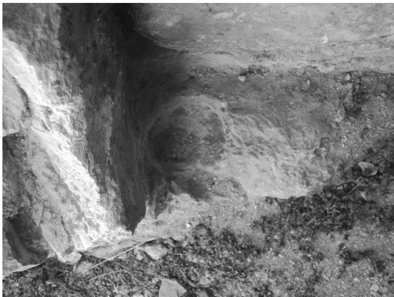
Εικ. 16. Διδυμότειχο, Πεντάζωνο. Υποδοχή στροφέως θύρας. Λήψη 2012.
