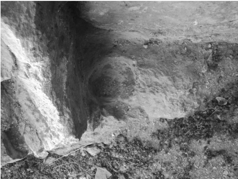
Εικ. 16. Διδυμότειχο, Πεντάζωνο. Υποδοχή στροφέως θύρας. Λήψη 2012.
