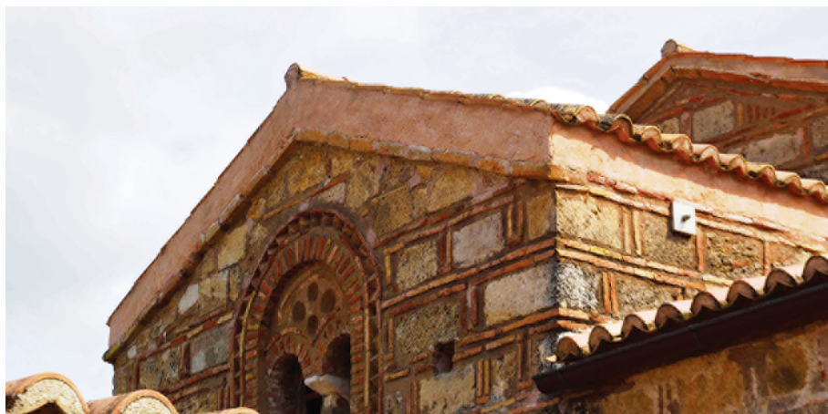
Εικ. 2: Παναγία Καθολική Γαστούνης, τέλη 13ου αι. Το τύμπανο του τόξου του δώλου- βου παραθύρου της δυτικής όψης με τις υποδοχές των αποκολλημένων αγγείων.
