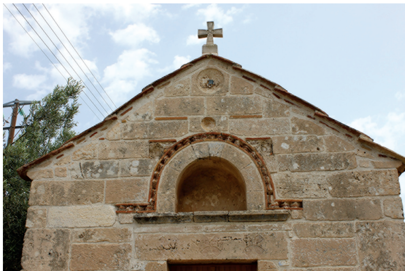
Εικ. 23: Αίγινα. Ομορφοκκλησιά. Άποψη της δυτικής όψης του ναού με εμφανή την πρακτική εντοιχισμένων αγγείων (φωτ. ΕΦΑ Πειραιώς και Νήσων, Υπουργείο Πολιτισμού).
