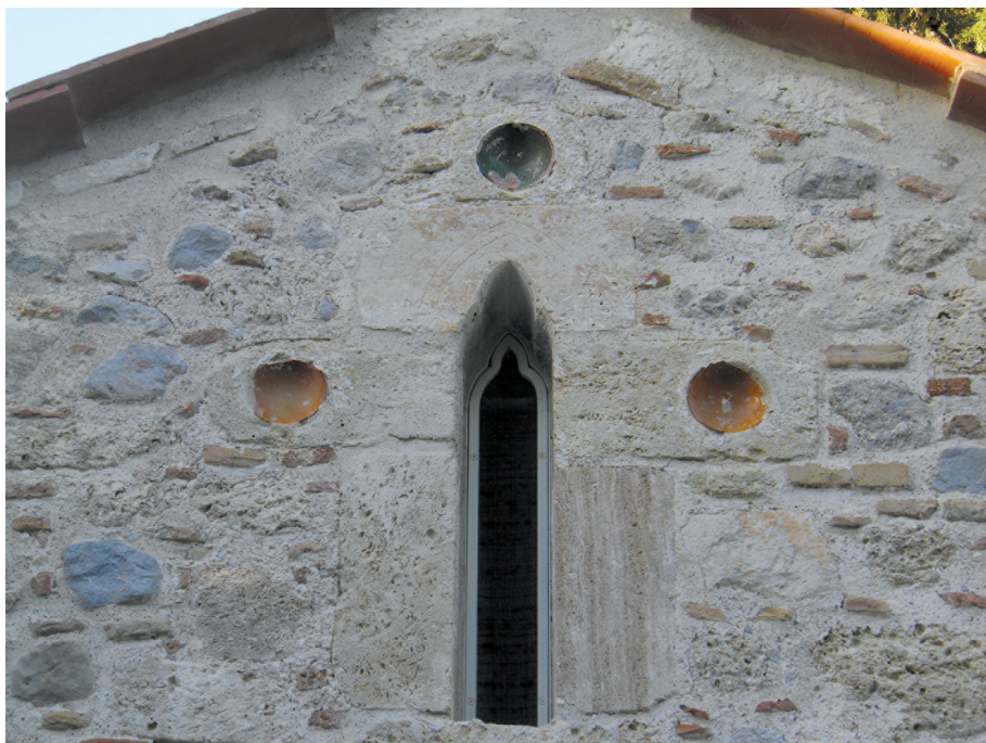
Εικ. 3: Άνω Αλεποχώρι. Μεταμόρφωση Σωτήρος. Εντοχισμένα αγγεία σε σειρά στην κορυφή της νότιας πλευράς της εγκάρσιας καμάρας (φωτ. Α. Γ. Γιαγκάκη).
