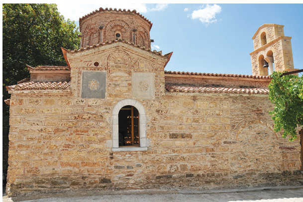
Εικ. 23: Κοίμηση Θεοτόκου Καστάνιας, βόρεια όψη.
