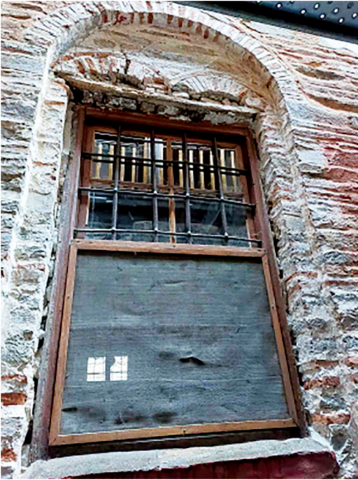
Είλ. 19. Τὸ νότιο παράθυρο τῆς λιτῆς μετὰ τὴν ἀφαίρεση τοῦ ἐπιχρίσματος. Στὸ ἐπάνω μέρος ξεχωρίζουν τὰ ὑπολείμματα ἀπὸ τὰ τόξα τῶν λοβῶν.
