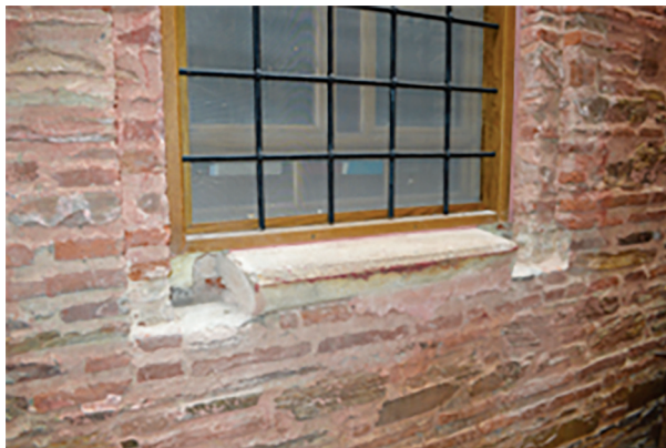
Εἰκ. 10. Τὸ παράθυρο τοῦ δεξιοῦ χοροῦ μετὰ τὸν κιονίσκο νὰ ξεχωρίζει ὡς περβάζι.
