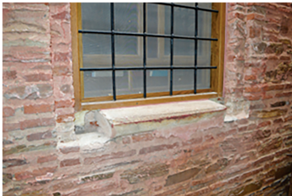
Εἰκ. 10. Τὸ παράθυρο τοῦ δεξιοῦ χοροῦ μὲ τὸν κιονίσκο νὰ ξεχωρίζει ὡς περβάζι.
