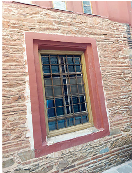
Εικ. 4. Τὸ παράθυρο τοῦ ἀριστεροῦ χοροῦ πρὶν τὴν ἀντικατάσταση (ἐξωτερικὴ ὄψη).
