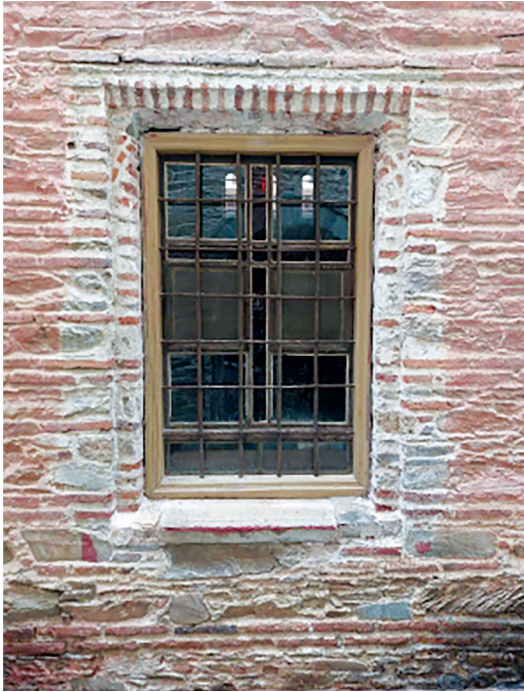
Εικ. 5. Τὸ παράθυρο τοῦ ἀριστεροῦ χοροῦ (ἐξωτερικὴ ὄψη) μετὰ τὴν ἀφαίρεση τοῦ ἐπιχρίσματος. Στὸ ἐπάνω μέρος φαίνονται ὑπολείμματα ἀπὸ τὰ τόξα τῶν λοβῶν.
