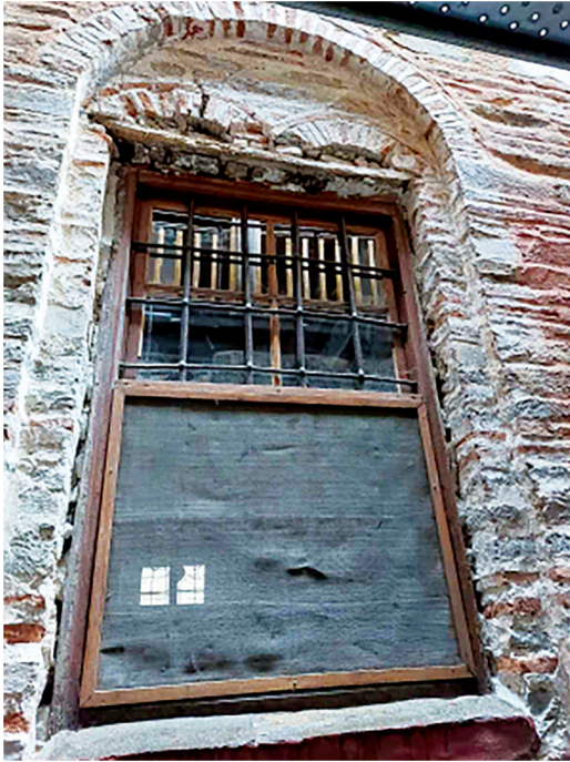
Είγ. 19. Τὸ νότιο παράθυρο τῆς λιτῆς μετὰ τὴν ἀφαίρεση τοῦ ἐπιχρίσματος. Στὸ ἐπάνω μέρος ξεχωρίζουν τὰ ὑπολείμματα ἀπὸ τὰ τόξα τῶν λοβῶν.
