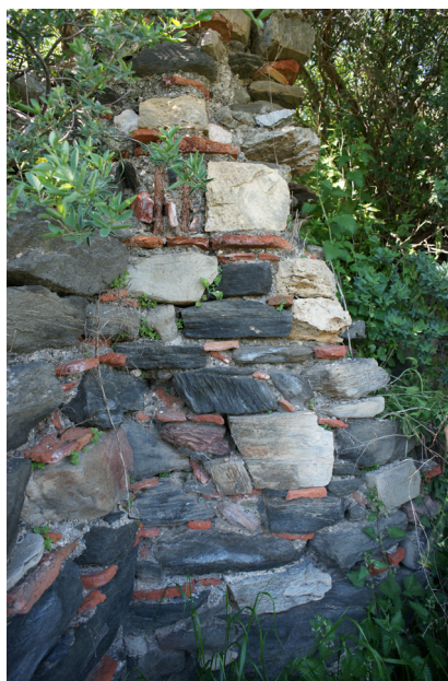
Εικ. 42. Κτητόρισσα, ερειπωμένος ναός, μερική άποψη βόρειας αψίδας από τα νοτιοανατολικά (2011).
