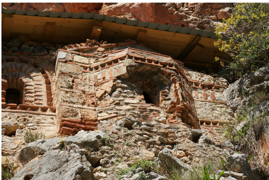
Εικ. 36. Ρέμα Σωφρόνη, Ασκητήριο Προδρόμου, άποψη της αψίδας (2011).
