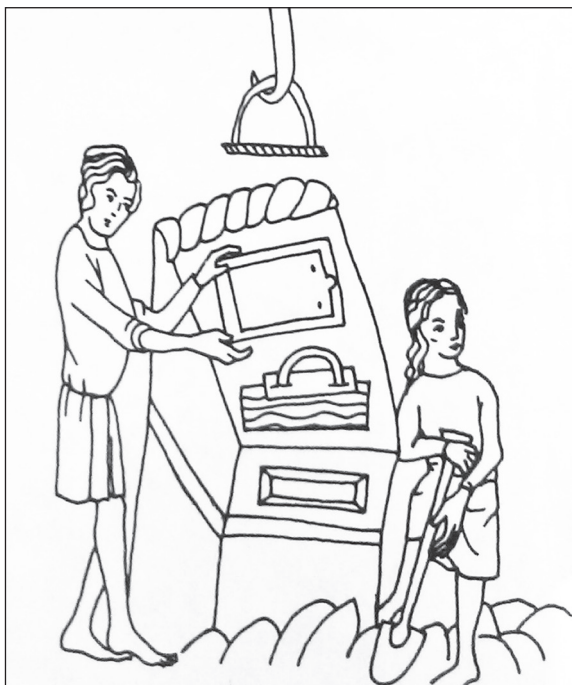
Εικ. 15. Μορφοποίηση πλίνθων. Μικρογραφία εικονογραφημένης Βίβλου, Ms. Phill. 1906, φ. 45ν, Βερολίνο, Κρατική Βιβλιοθήκη (1368) (BINDING, Der Mittelalterliche Baubetrieb , σφ. 74).
