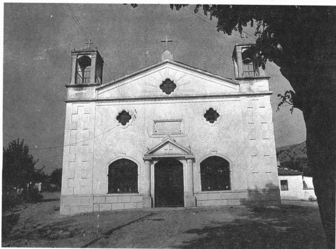
37. Εὐλάμπιο, Ἁγία Βαρβάρα: δυτικὴ πλευρὰ
