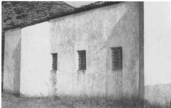
30. Γλυκύ, Κοίμηση Θεοτόκου: αντηρίδες βόρειας πλευράς
