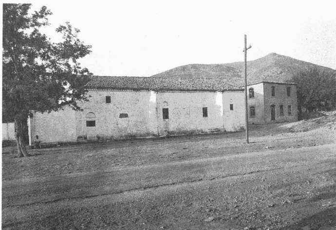
31. Σχοινοῦδι, Ἁγία Μαρίνα: νότια πλευρά
