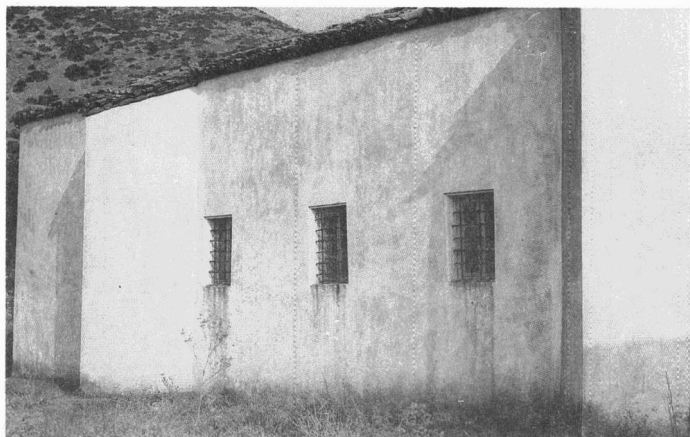
30. Γλυκύ, Κοίμηση Θεοτόκου: άντηρίδες βόρειας πλευράς
