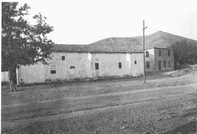
31. Σχοινοῦδι, Ἁγία Μαρίνα: νότια πλευρά
