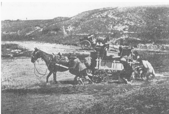
6. Μεταφορικά μέσα σὲ κάποιες περιοχὲς τῆς Μακεδονίας: Δομικὰ ὑλικά γιὰ τὴν κατασκευὴ ἑνὸς χωριοῦ
