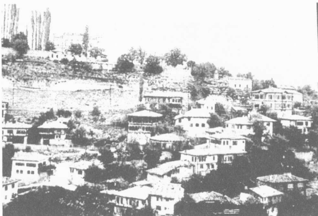
Εικ. 1. Άποψη τῆς τουρκικῆς συνοικίας τῆς Σαφράμπολης. Στὸ κέντρο διακρίνεται τὸ παλιὸ Διοικητήριον. Στὸ ἀριστερὸ ἄκρο τῆς εἰκόνας, ἐπάνω στὸ λόφο, μόλις ποὺ διακρίνεται ὁ ναὸς τοῦ Ἁγίου Στεφάνου (Ulu Cami).
