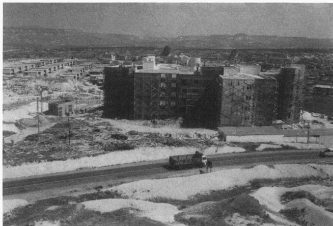
Fig. 2. Ortahisar. L'hotel Lapis et ses pavillons, en construction (1987).
