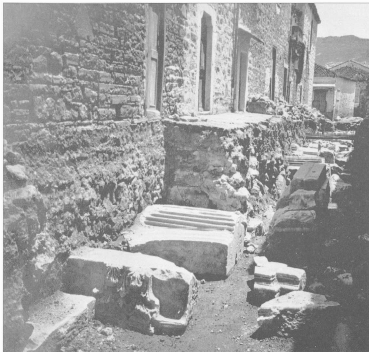
Είχ. 2. Λεπτομέρεια από το «chantier 1» (βλ. σ. 61).
