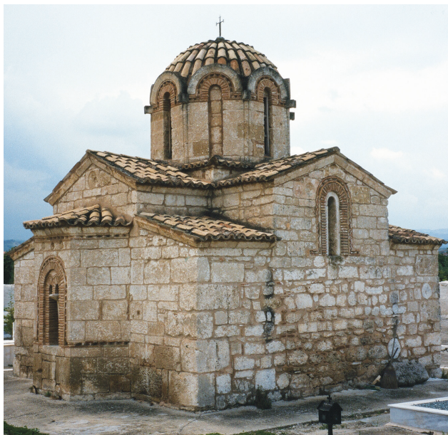
Εικ. 16. Ταρσινά Κορινθίας, Μεταμόρφωση. Άποψη από τα βορειοανατολικά (2004).
