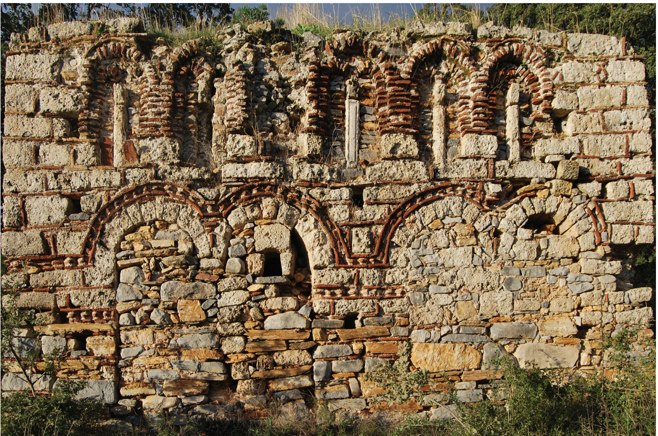
Εικ. 10. Καστάνια Μεσσηνιακής Μάνης, Αι Στράτηγος στη θέση Νικόκαστρο. Νότια όψη (2010).
