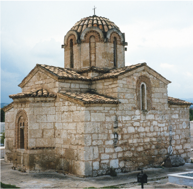
Εικ. 16. Ταρσινά Κορινθίας, Μεταμόρφωση. Άποψη από τα βορειοανατολικά (2004).
