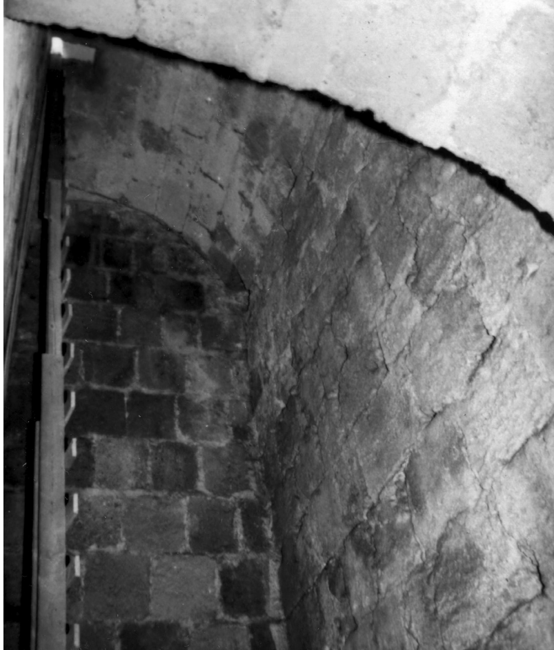
Εικ. 2. Ρόδος. Προμαχώνας Αγίου Γεωργίου. Εσωτερικό του βόθρου της Ιπποτοκρατίας.
