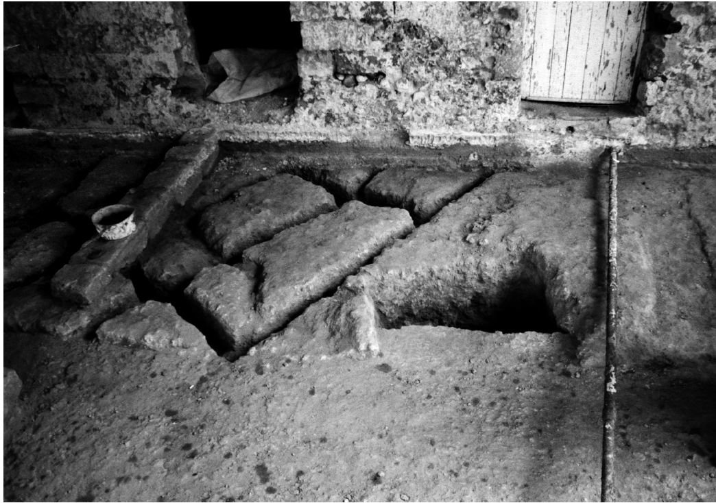
Εικ. 10. Ρόδος, Ξενώνας Αγίας Αικατερίνης. Μερική άποψη λαξευμάτων αρχαίου λατομείου και της κάλυψης της υδατοδεξαμενής.
