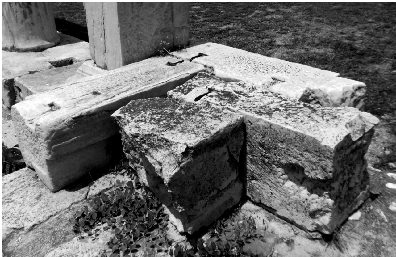
Εικ. 3. Αθήνα, Βιβλιοθήκη του Αδριανού. Τετράκογχο, τοιχοδομία στην νοτιοανατολική γωνία.
