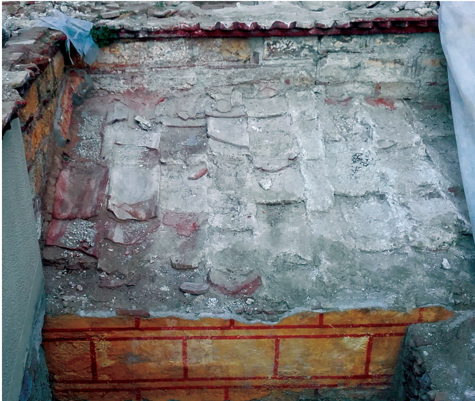
Εικ. 10. Αθήνα, Μεταμόρφωση του Σωτήρα (Σώτεια του Κοττάκη). Αποψη από τα νότια των καταλοίπων της στέγης του νοτιοανατολικού γωνιακού διαμερίσματος και της μεταβατικής καμάρας.
