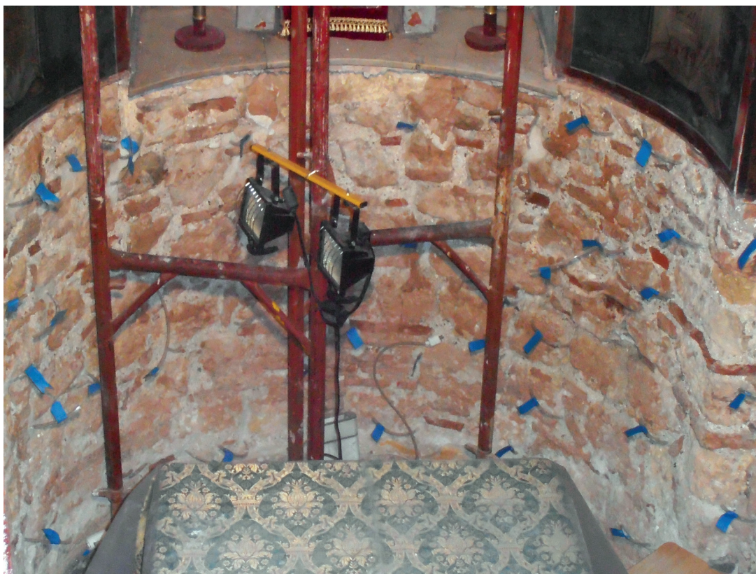
Εικ. 4. Αθήνα, Μεταμόρφωση του Σωτήρα (Σώτεια του Κοττάκη). Αψίδα ιερού, εσωτερική όψη της τοιχοποιίας κατά τη διάρκεια των εργασιών.
