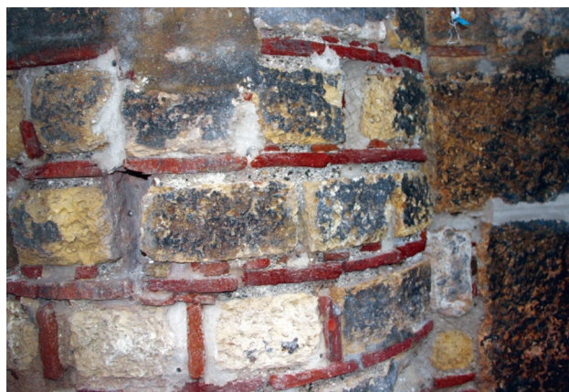
Εικ. 2. Αθήνα, Μεταμόρφωση του Σωτήρα (Σώτεια του Κοττάκη). Βόρεια αψίδα, λεπτομέρεια της τοιχοποιίας κατά τη διάρκεια των εργασιών.
