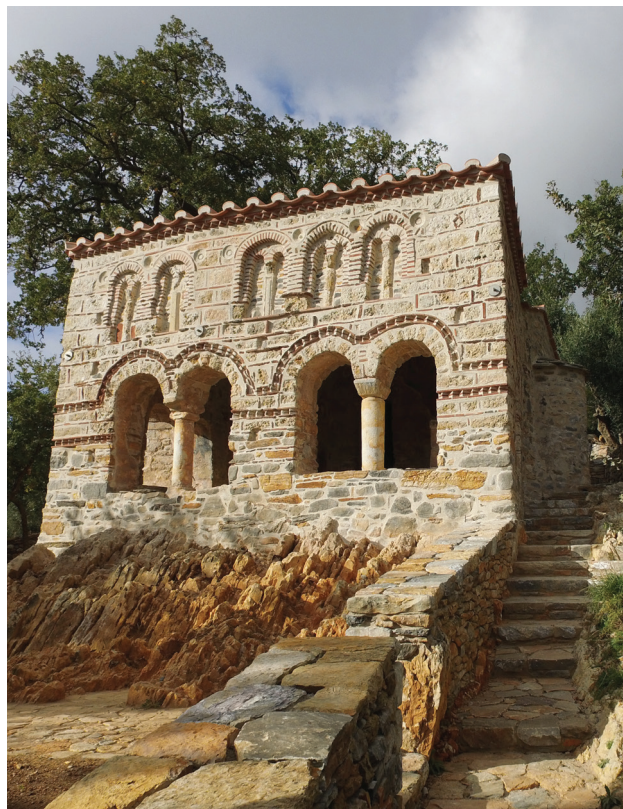
Εικ. 2. Μεσσηνιακή Μάνη, Άι Στράτηγος Καστάνιας. Άποψη της στοάς από τα νοτιοανατολικά, μετά την ολοκλήρωση των εργασιών αποκατάστασης.
