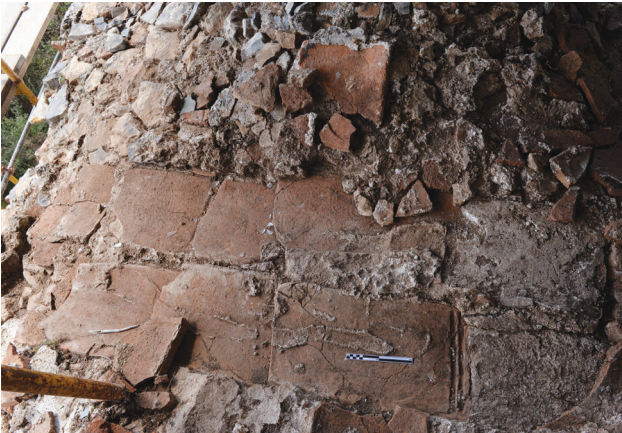
Εικ. 11. Μεσσηνιακή Μάνη, Άι Στράτης Καστάνιας. Η αρχική κεραμοσκεπή της στοάς στο τμήμα μεταξύ των δύο θόλων.
