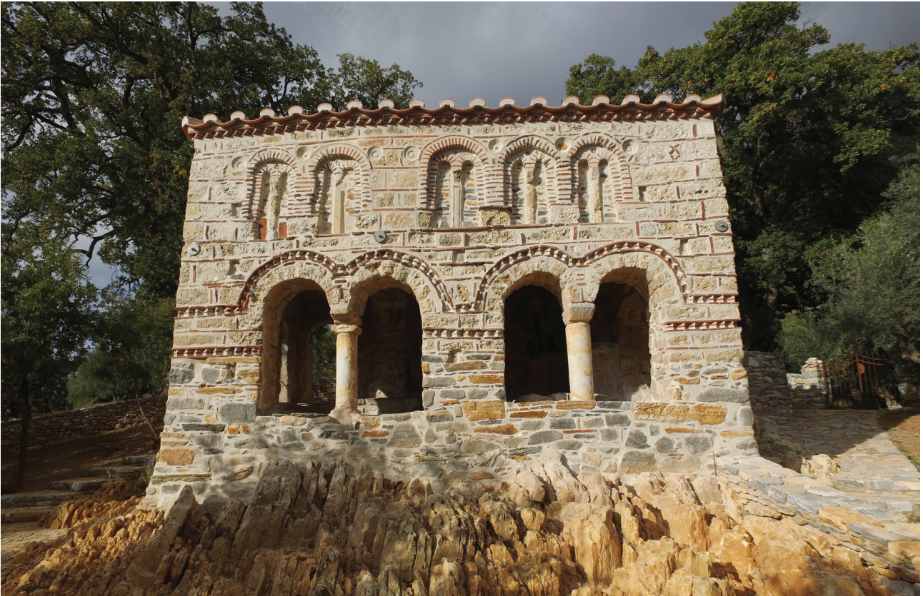
Εικ. 9. Μεσσηνιακή Μάνη, Αι Στράτηγος Καστάνιας. Νότια όψη, μετά την ολοκλήρωση των εργασιών.
