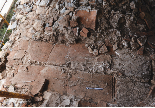
Εικ. 11. Μεσσηνιακή Μάνη, Άι Στράτηςος Καστάνιας. Η αρχική κεραμοσκεπή της στοάς στο τμήμα μεταξύ των δύο θόλων.
