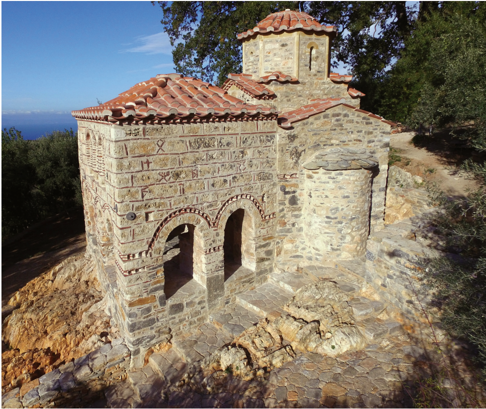
Εικ. 7. Μεσσηνιακή Μάνη, Άι Στράτηγος Καστάνιας. Αποψη του μνημείου από τα νοτιοανατολικά, μετά την ολοκλήρωση των εργασιών και την ανακατασκευή του τρούλου.
