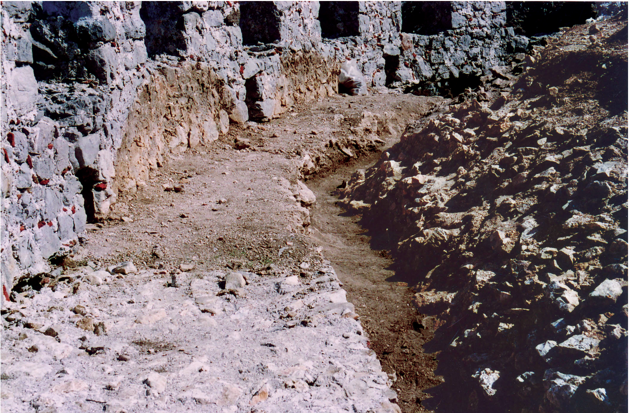
Εικ. 6. Χίος, Πιτύος. Ο πύργος. Το δώμα του πύργου κατά τη διάρκεια των εργασιών.
