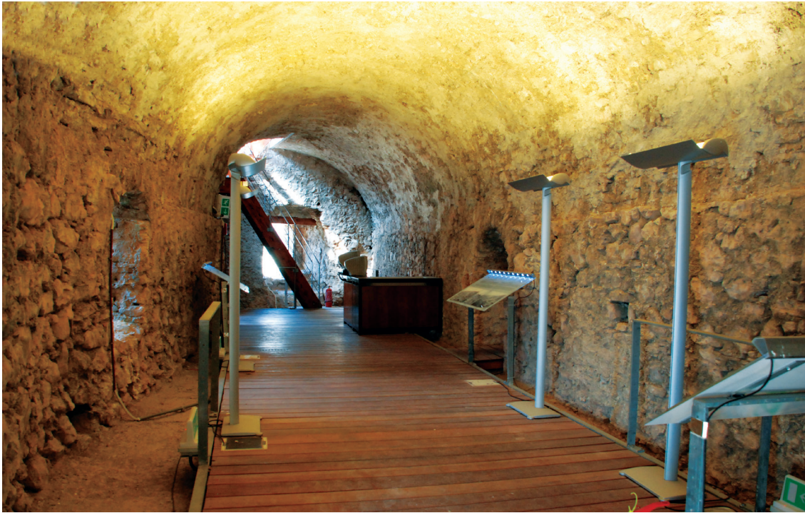
Εικ. 3. Χίος, Πιτύος. Ο πύργος. Ο νότιος χώρος του ορόφου.
