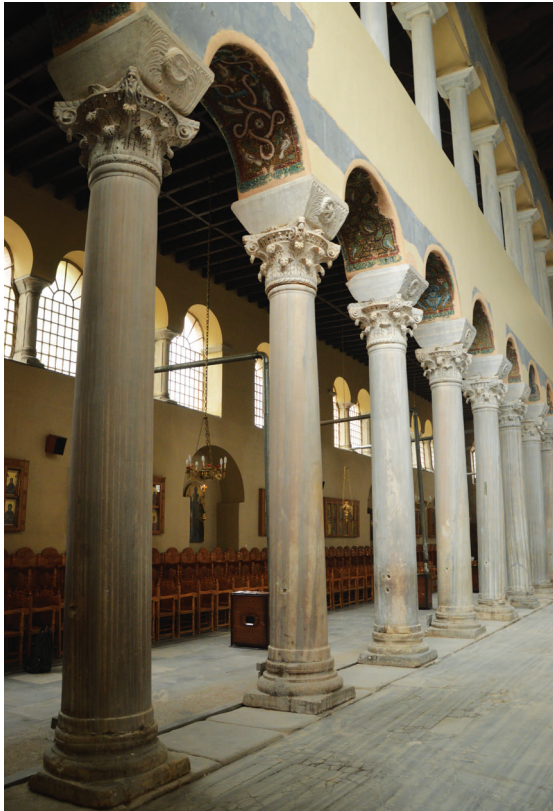
Εικ. 12. Αχειροποίητος, άποψη της βόρειας κιονοστοιχίας, από δυτικά.
