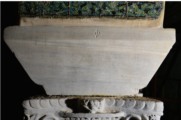
Εικ. 25. Αχειροποίητος, η ανατολική ακόσμητη πλευρά του επιθήματος του τέταρτου, από δυτικά, κίονα της νότιας κιονοστοιχίας, όπου υπάρχει τεκτονικό χάραγμα Θ ή Φ.
