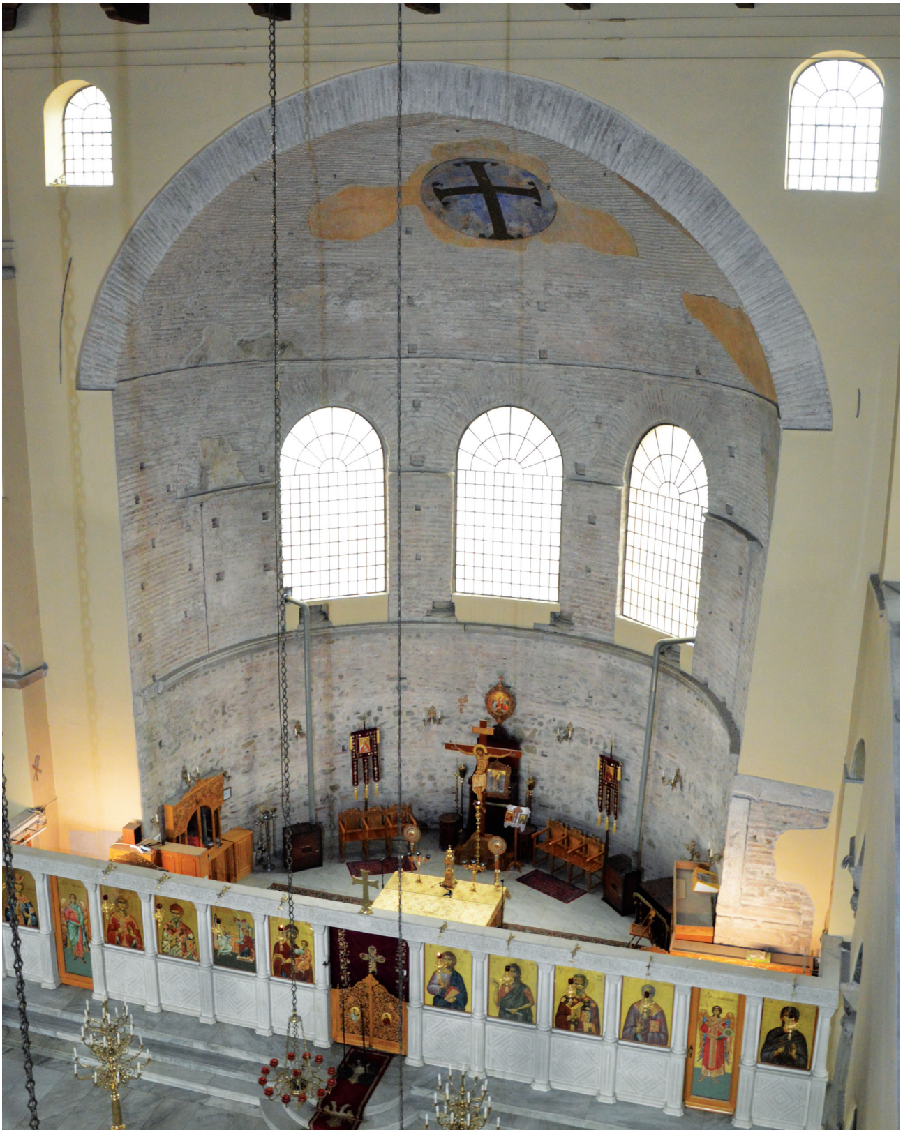
Εικ. 15. Αχειροποίητος, άποψη του εσωτερικού της αψίδας, από νοτιοδυτικά.
