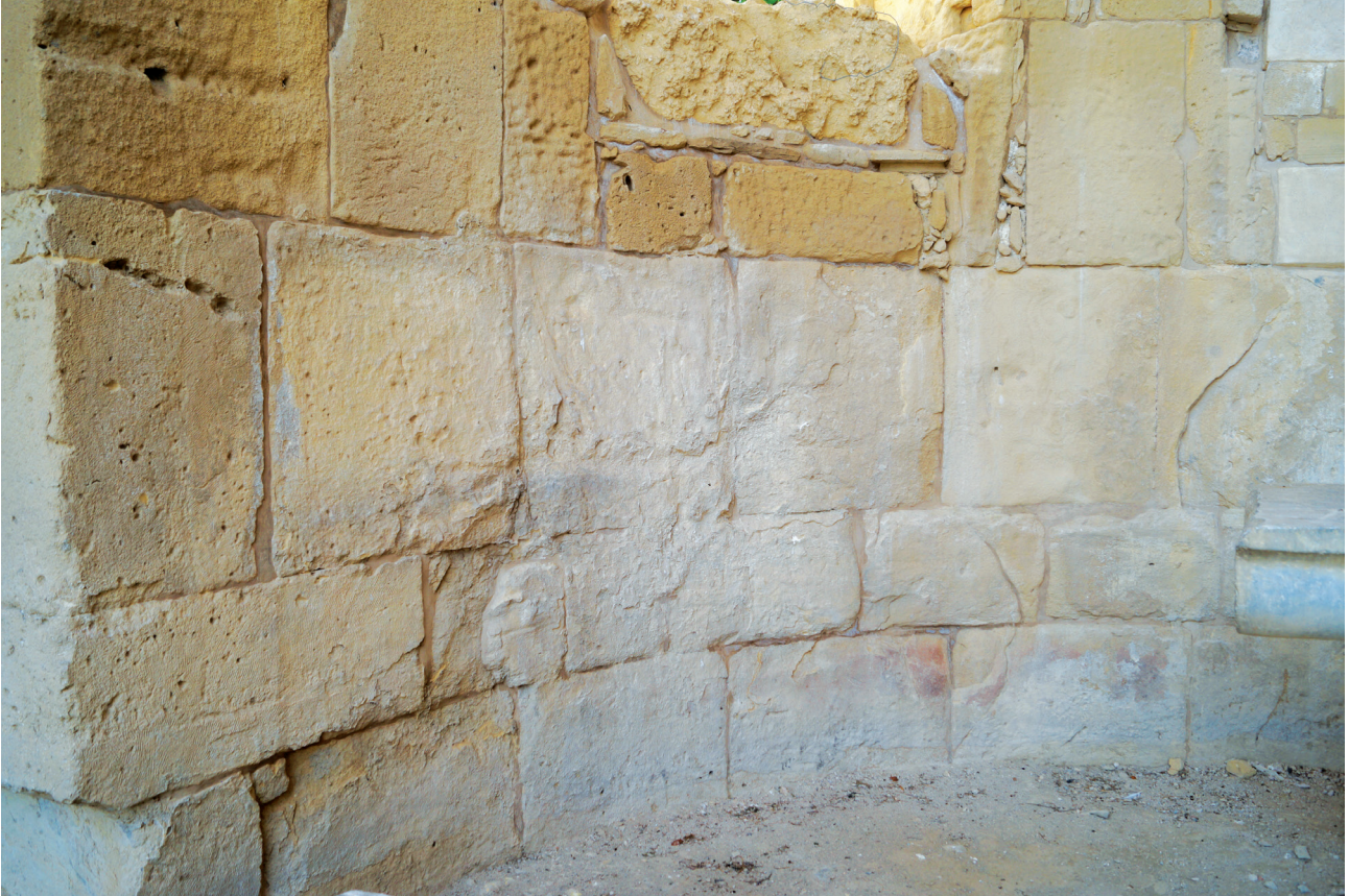
Εικ. 16. Εσωτερική όψη της κεντρικής αψίδας του ιερού, κάτω από το βόρειο παράθυρο: αρχική ψευδοϊσόδομη κατασκευαστική φάση.
