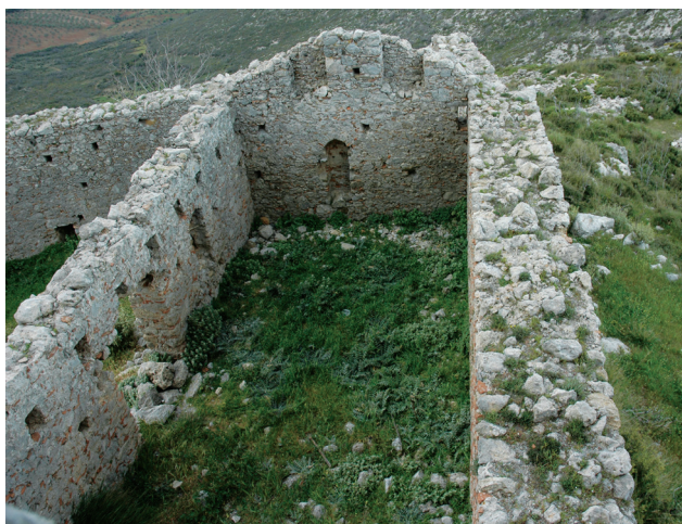
Εικ. 20. Κτήριο-κατοικία. Αποψη από Β.
