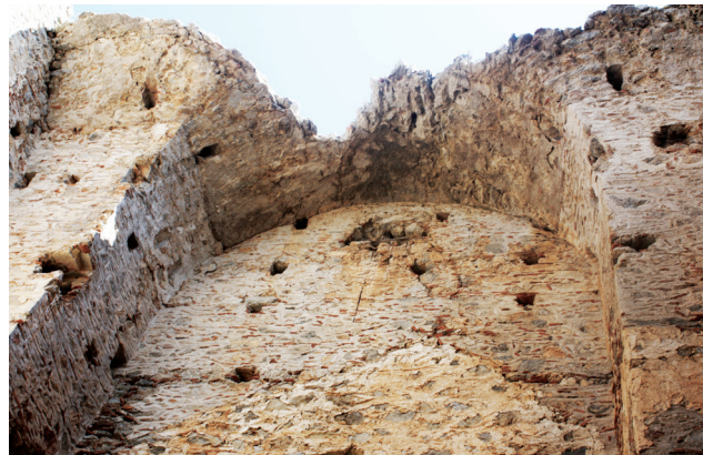
Εικ. 13. Κεντρικός πύργος. Ανατολικό τμήμα σταυροθολίου γ' στάθμης.
