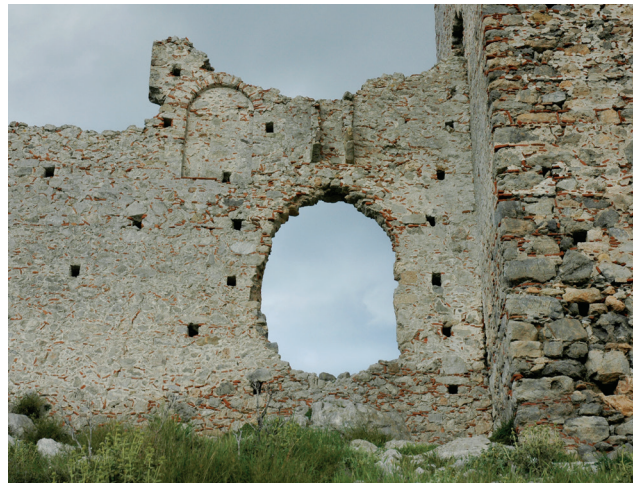
Εικ. 19. Πύλη. Δυτική όψη.
