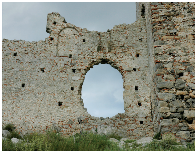
Εικ. 19. Πύλη. Δυτική όψη.
