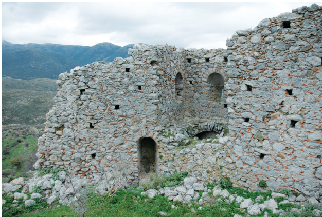
Εικ. 22. Νοτιοανατολικός πύργος και πλησιόχωρο αποχωρητήριο. Αποψη από ΒΑ.
