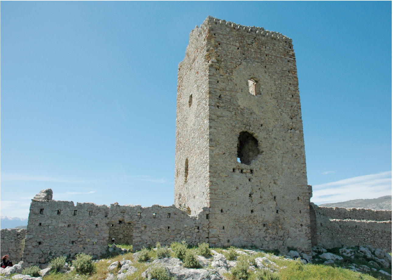
Εικ. 15. Κτήριο-κατοικία – Κεντρικός πύργος – Πύλη. Άποψη από ΝΑ.
