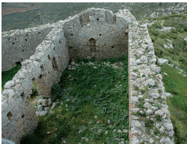
Εικ. 20. Κτήριο-κατοικία. Αποψη από Β.
