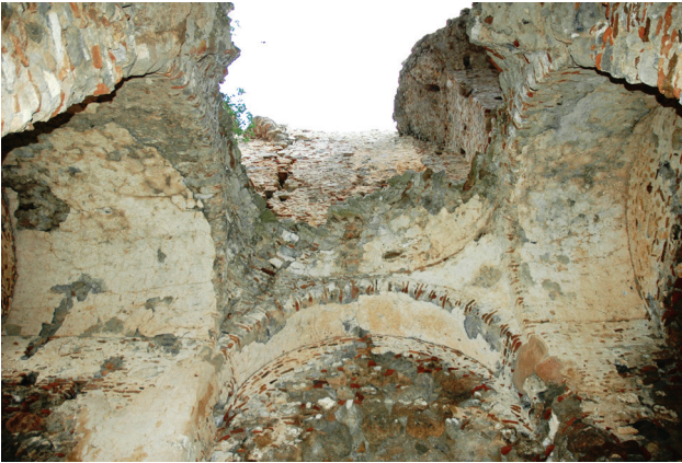
Εικ. 6. Κεντρικός πύργος. Στοιχεία κάλυψης βόρειου χώρου στη β' στάθμη: ασπίδα επί λοφίων, δύο ημικυλινδρικές καμάρες και ημικυκλικό τόξο.
