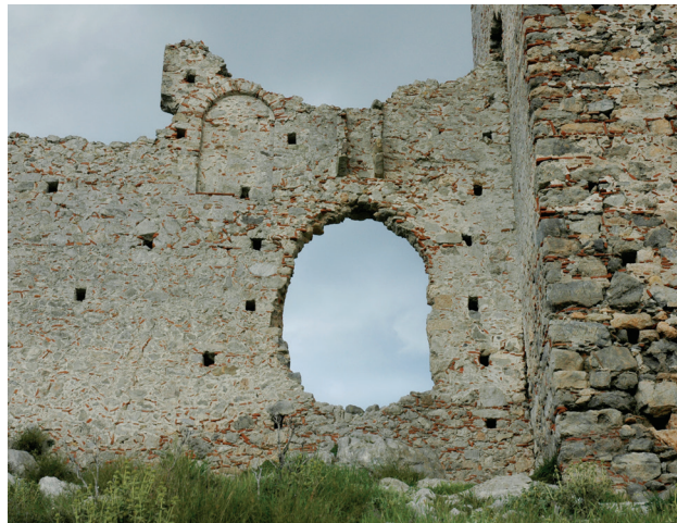
Εικ. 19. Πύλη. Δυτική όψη.
