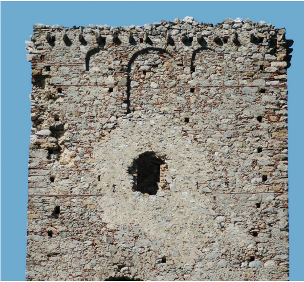
Εικ. 16. Κεντρικός πύργος. Ανατολική εξωτερική όψη, λεπτομέρεια ανωδομής.
