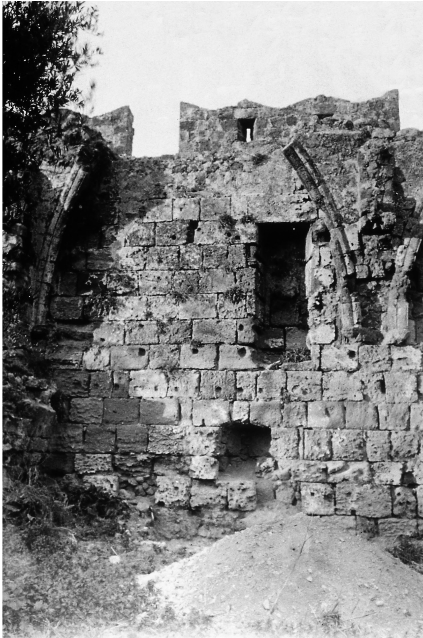
Εικ. 4. Άποψη του βόρειου τείχους, όπου διακρίνονται οι δύο οικοδομικές φάσεις του συγκροτήματος μεσαιωνικών κτισμάτων (ιταλικό φωτογραφικό αρχείο της Εφορείας Αρχαιοτήτων Δωδεκανήσου).
