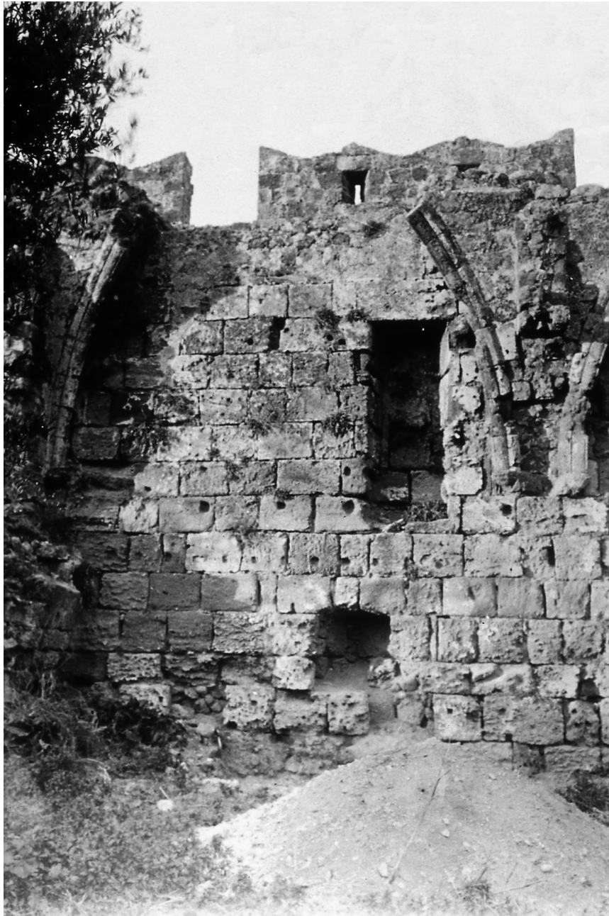
Εικ. 4. Άποψη του βόρειου τείχους, όπου διακρίνονται οι δύο οικοδομικές φάσεις του συγκροτήματος μεσαιωνικών κτισμάτων (ιταλικό φωτογραφικό αρχείο της Εφορείας Αρχαιοτήτων Δωδεκανήσου).
