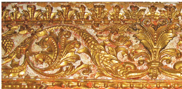
Fig. 11. Kourdali, poutre à rinceaux de l'iconostase, détail (photographie septembre 2007).
