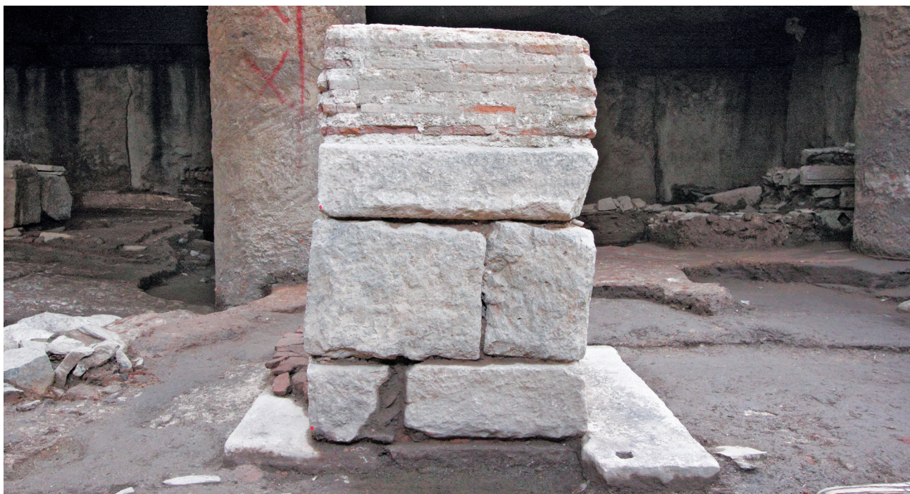
Εικ. 9. Θεσσαλονίκη, σταθμός Βενιζέλου. Ο νοτιοδυτικός κεντρικός πεσσός του τετραπύλου, βόρεια όψη (πρβλ. Εικ. 8).
