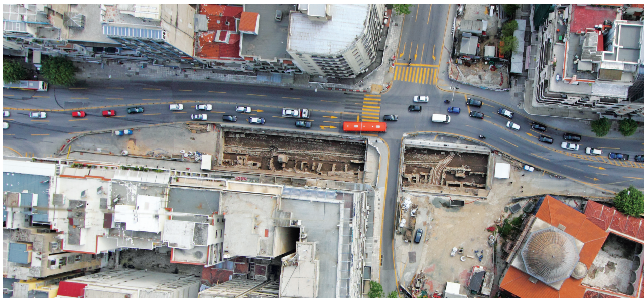
Εικ. 1. Θεσσαλονίκη, ο σταθμός Βενιζέλου στη συμβολή των οδών Εγνατία και Βενιζέλου. Αεροφωτογραφία.
