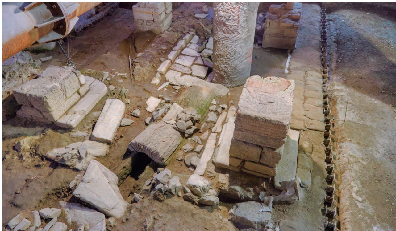
Εικ. 8. Θεσσαλονίκη, σταθμός Βενιζέλου. Ο μαρμαρόστρωτος cardo με τον κεντρικό καμαροσκεπή αγωγό. Διακρίνονται οι τέσσερις προς νότο πεσσοί του τετραπύλου. Άποψη από τα βόρεια.
