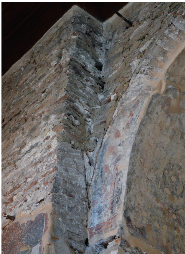
Εικ. 17α, β. Μονή Λατόμου (Όσιος Δανίδ), καθολικό. Αποψη του σημείου σύγκλισης της καμάρας της ανατολικής κεραίας με την καμάρα της βόρειας (αριστερά) και της νότιας (δεξιά) κεραίας του πρωτοβυζαντινού σταυρικού ναού. Διακρίνονται οι γενέσεις των λοφίων του ημισφαιρικού θόλου του κεντρικού χώρου.
