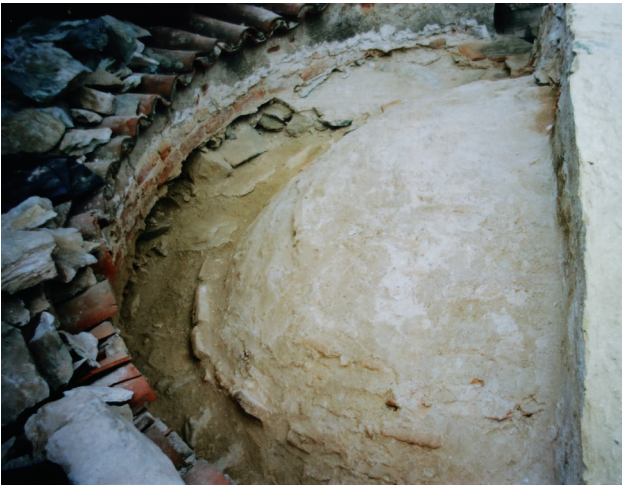
Εικ. 20α, β. Μονή Λατόμου (Όσιος Δανίδ), καθολικό. Το εξωράχιο της καμάρας και του τεταρτοσφαιρίου της αψίδας του ιερού κατά τις εργασίες αποκατάστασης των στεγών του ναού την περίοδο 2000-2001.
