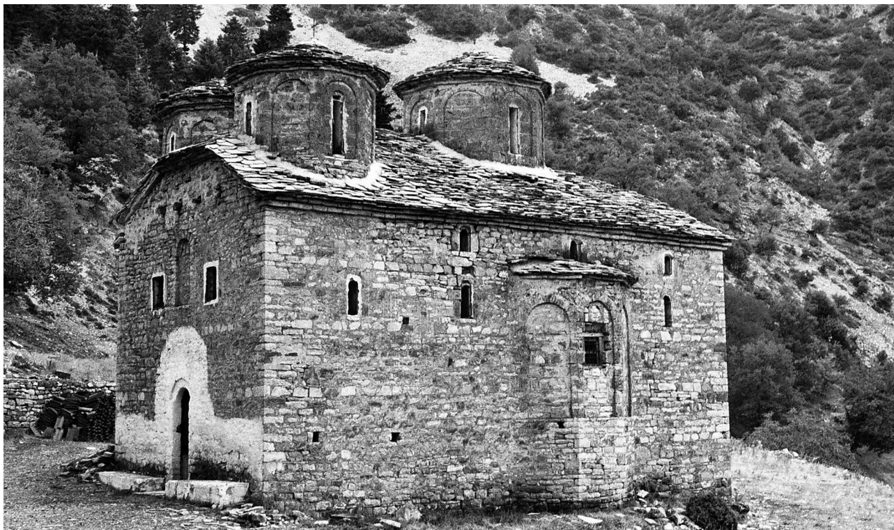
Εἰκ. 17. Καλαμπάκα. Τό καθολικό τῆς μονῆς Κλεινοῦ. Ἡ δυτική καί ἡ νότια πλευρά. Ἀποψη ἀπό νοτιοδυτικά.
