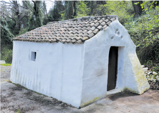
Εικ. 1. Άποψη του ναού από τα βορειοδυτικά.
