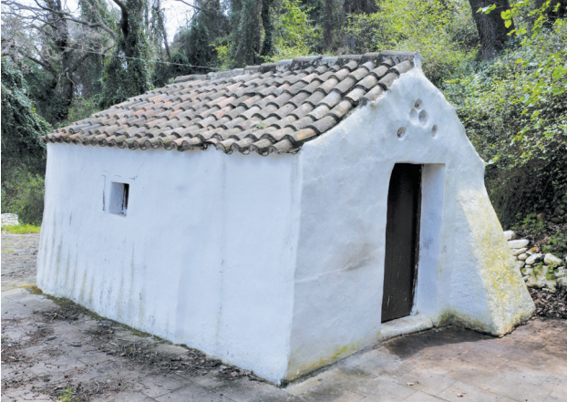
Εικ. 1. Άποψη του ναού από τα βορειοδυτικά.
