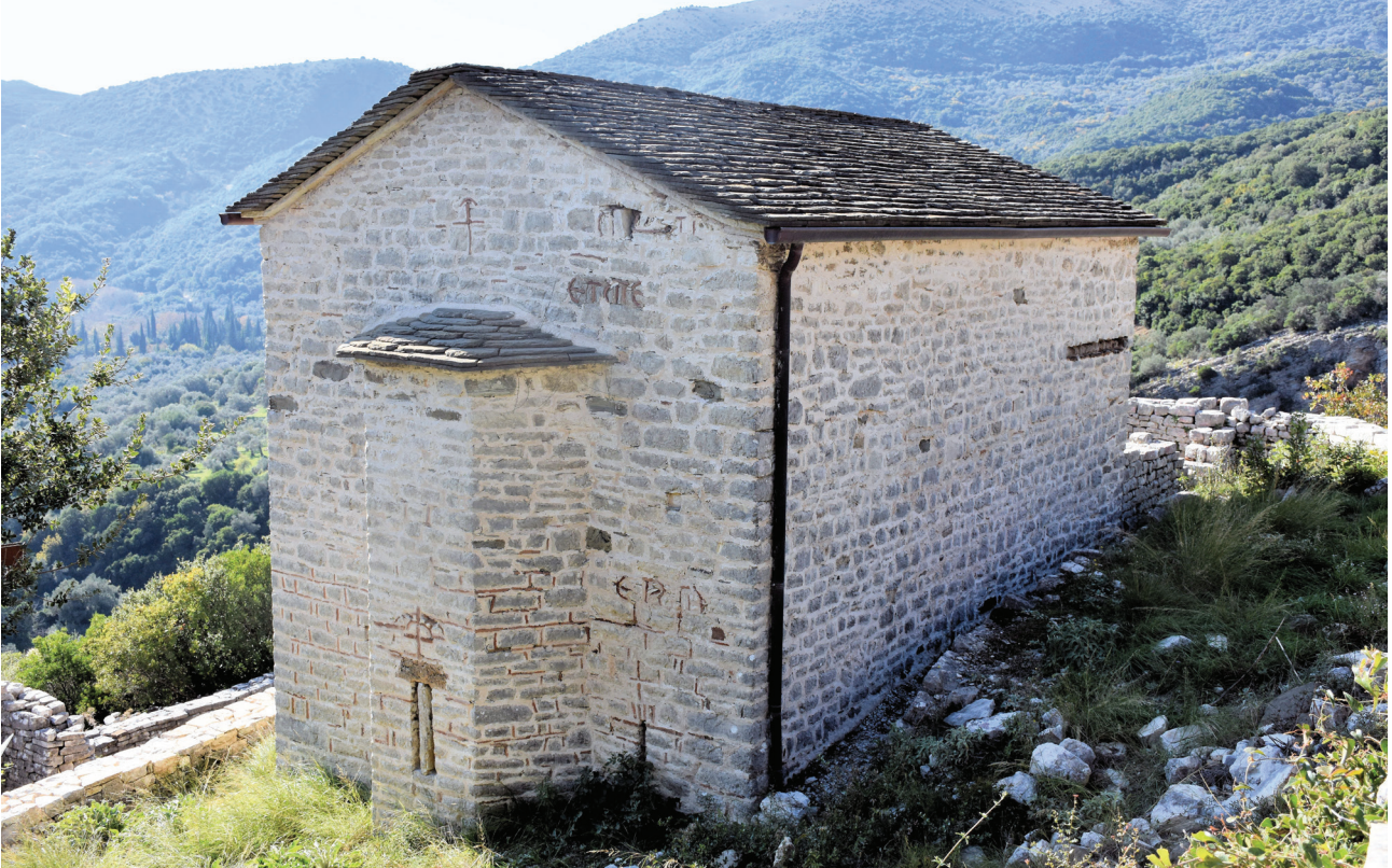
Εικ. 1. Ναός Ταξιαρχών Ουζντίνας, άποψη από τα βορειοανατολικά.
