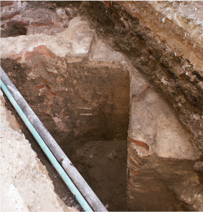
Εικ. 4. (α) και (β). Τμήμα της ανατολικής πλινθόκτιστης τοιχοποιίας του εξεταζόμενου κτηρίου.
