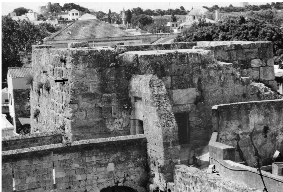
Εικ. 6. Άποψη των υπολειμμάτων της άνω στάθμης του πρωτοβυζαντινού πύργου B11 (πρβλ. Εικ. 4) στο επίπεδο κυκλοφορίας του περιδρόμου του τείχους (έτος λήψης 2002).
