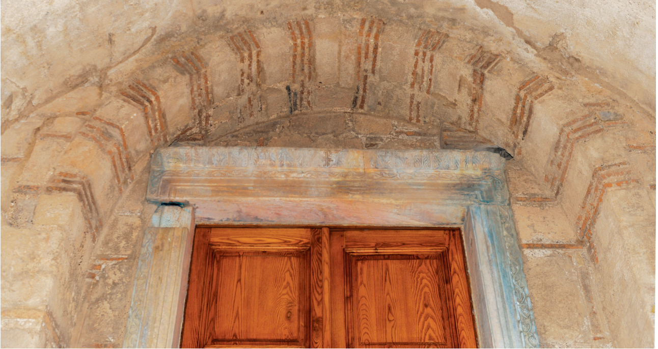
Εικ. 10. Χριστιάνοι Τριφυλίας, ναός Σωτήρος Χριστού. Λεπτομέρεια του ανακουφιστικού τόξου της δυτικής θύρας εισόδου στον ναό.
