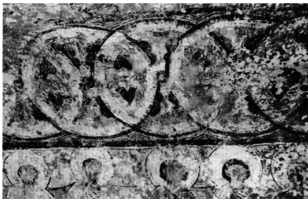
Fig. 10. Saint-Michel : voûte de la nef.
