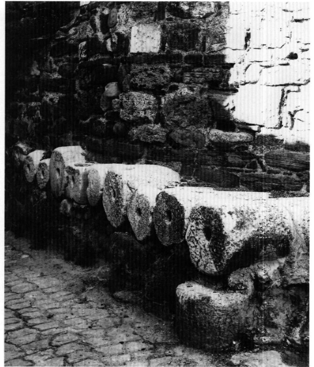
Εικ. 18. Τρίγλεια. Ναός Παντοβασιλίσσας. Η θεμελίωση της ανατολικής πλευράς του ναού (Ιούλιος 2001) (φωτ. Χ. Μπούρας).
