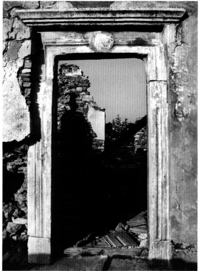
Εικ. 14. Σύρος, Πισκοπιό. Κατοικία επισκόπων. Το θύρωμα της εισόδου.
