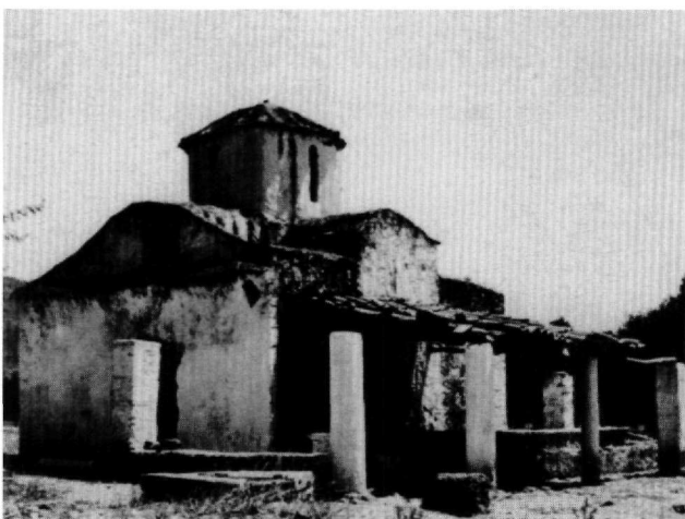
Εικ. 8. Αποψη του ναού από νοτιοδυτικά (φωτ. 1935, Μεγαρέων καταφύγια, εικ. 25).
