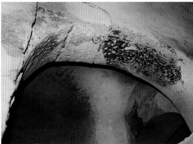
Εικ. 11. Τχνη διακοσμητικού θέματος στο εσωρράχιο του διαμήκους τόξου του διακονικού.
