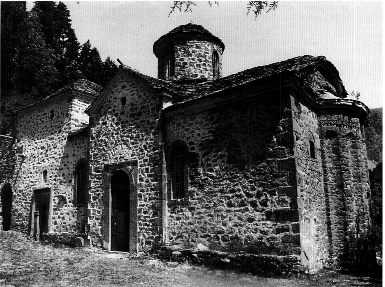
Εικ. 1. Άγια Τριάδα στη Δέση Τρικάλων. Άποψη από νοτιοανατολικά.
