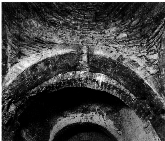
Εικ. 2. Νάρθηκας. Δεύτερο τόξο για την έδραση του νότιου φουρνικού.
