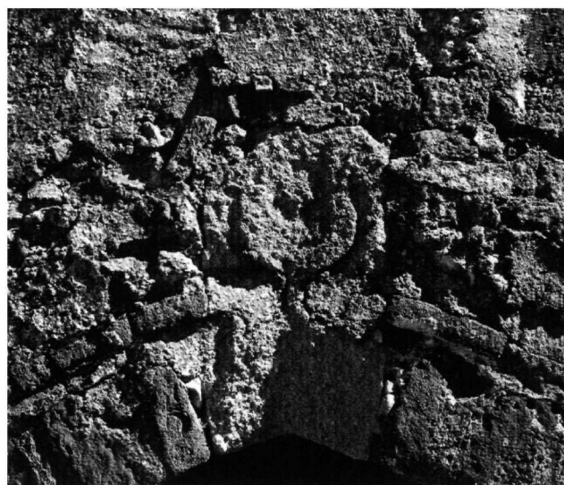
Εικ. 4. Νότια είσοδος στο νάρθηκα. Στο κλειδί του τόξου ανεστραμμένη ημισέληνος που περικλείει αστέρα.
