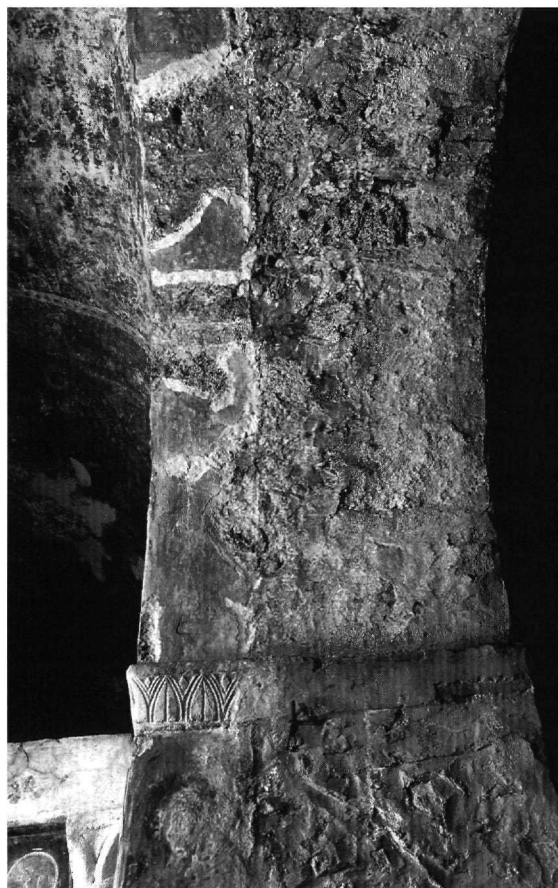
Εικ. 7. Εσωρράγιο νότιον τόξον προς το μεταγενέστερο νό- τιο κλίτος. Διακρίνονται τα τοιχογραφημένα τμήματα του αρχικού τυφλού αφιδώματος.
