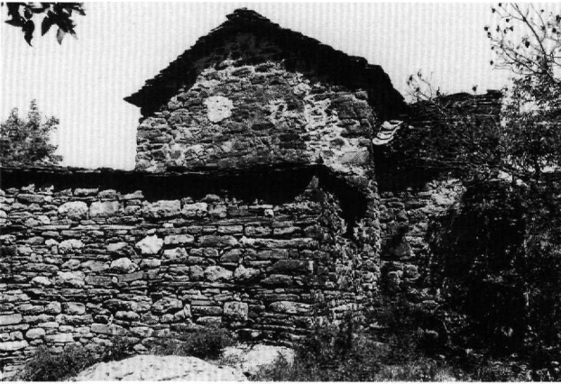
Abb. 1. Cerskë, Marienkirche. Ansicht von Südosten.
