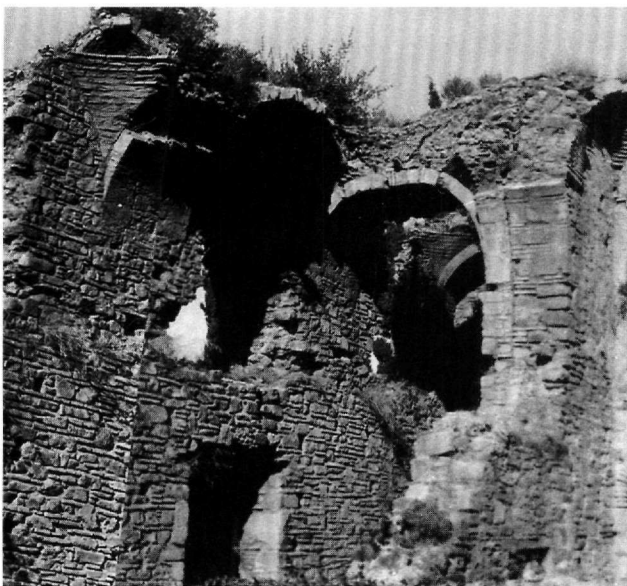
Εικ. 13. Ναός Μεταμορφώσεως του Σωτήρος Χριστιάνων. Διακρίνονται οι δοκοφωλεές του μεσοπατώματος του εξω-νάρθηκα και το οριζόντιο υπέρθυρο της δυτικής θύρας (φωτογραφία Στίκα).
