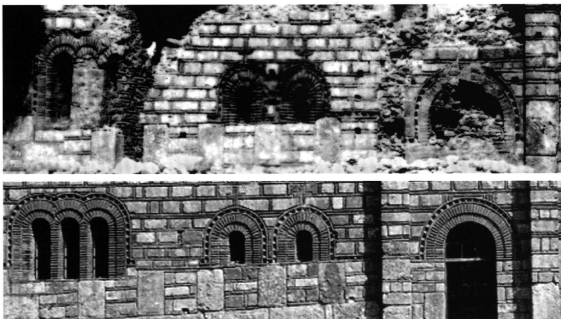
Εικ. 16. Ναός Μεταμορφώσεως του Σωτήρος Χριστιάνων. Συγκριτική αντιπαράθεση σημερινής κατάστασης (κάτω) και φωτογραφίας Λαμπάκη (επάνω) πριν από την έναρξη των εργασιών.
