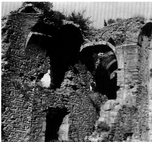
Εικ. 13. Ναός Μεταμορφώσεως του Σωτήρος Χριστιάνων. Διακρίνονται οι δοκοφωλεές του μεσοπατώματος του εξω-νάρθηκα και το οριζόντιο υπέρθυρο της δυτικής θύρας (φωτογραφία Στίκα).
