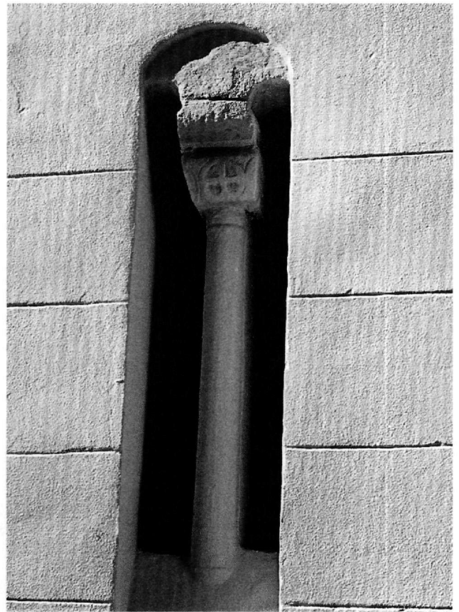
Εἰκ. 5. Μέγαρα. Ναός τῶν Ἁγίων Ἑξι Μαρτύρων. Ὁ ἀμφικιονίσκος μέ τό ἐπίθημα στό παράθυρο τῆς ἀψίδας τοῦ Ἱεροῦ (β' μισό 5ου αἰ.).
