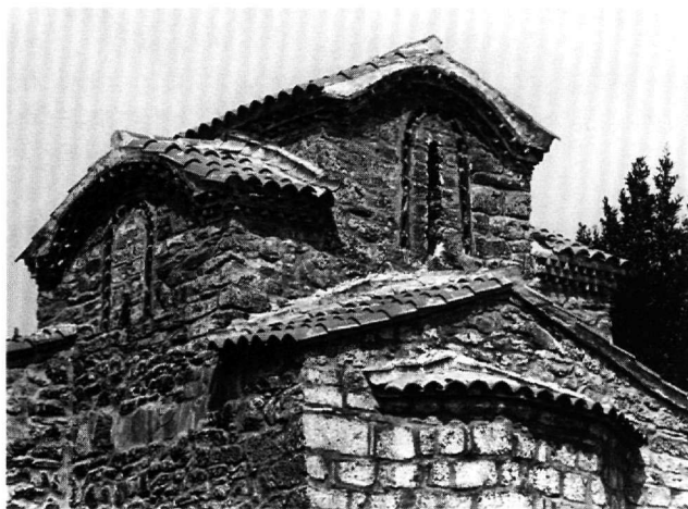
Εικ. 6-7. Οί Ταξιάρχες στό Έλάφι Καλαμπάκας. Ἡ διάρθρωση τῶν στεγῶν τοῦ ἀρχικοῦ ναοῦ ἀπό νοτιοανατολικά καί ἀπό βορειοδυτικά ἀντιστοιχῶς.
