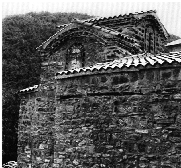
Εικ. 6-7. Οί Ταξιάρχες στό Έλάφι Καλαμπάκας. Ἡ διάρθρωση τῶν στεγῶν τοῦ ἀρχικοῦ ναοῦ ἀπό νοτιοανατολικά καί ἀπό βορειοδυτικά ἀντιστοίχως.
