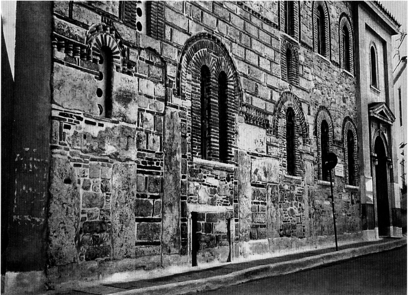
Εικ. 5. Η βόρεια όψη.
